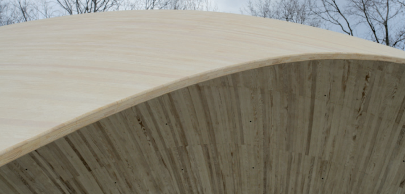
Abbildung 11: Beispiel für moderne Architektur mit dem Werkstoff Holz: Dachfläche von 10 Metern Spannweite bei nur 4 cm Materialstärke 12
