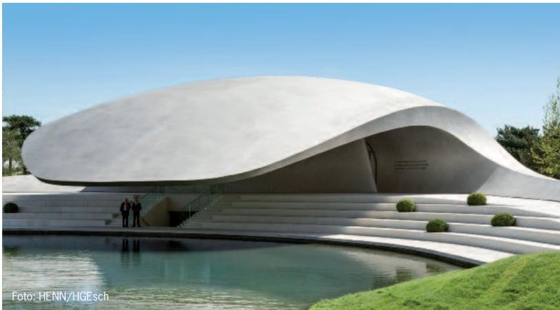
Beim Porsche Pavillon in der Autostadt Wolfsburg ist alles anders als bei üblichen Stahlbauten. Die Trennung von Dach und Fassade ist aufgehoben, der Baukörper amorph, statt geometrischen Grundformen folgend. Und die gesamte Schale übernimmt tragende Funktion. Gekrümmte Linien und rasante Kurven machen das Bauwerk zu einer dynamischen Skulptur, die charakteristische Elemente der ausgestellten Sportwagen architektonisch umsetzt.
