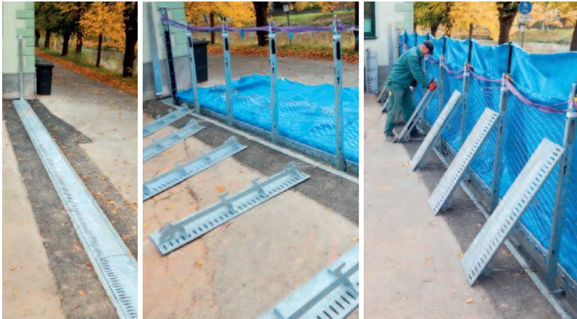
Starke Regenfälle können Sturzfluten freisetzen und Überschwemmungen auslösen. Anwohner eines Flusses mit starker Strömung und geringer Hochwasser-Vorwarnzeit suchten nach Alternativen zu blickdichten Flutmauern aus Beton. Sie sollten das Stadtbild unberührt lassen und trotzdem schnell zu errichten und sicher sein. Genau diese Möglichkeit bietet die AquaWand.
